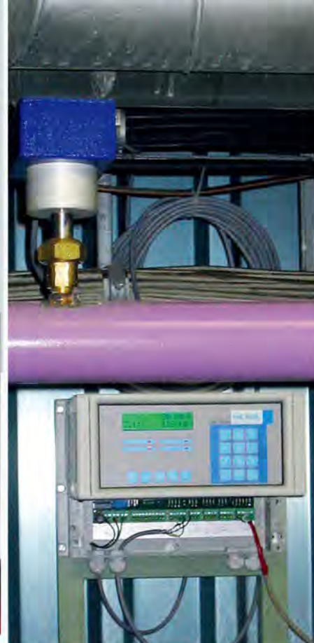
Elektronik mit abschraubbarem Sensor/ Electronics and detachable sensor
