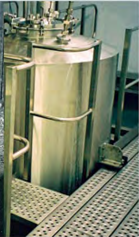
带有防脱轨装置的清洁型称重模块
