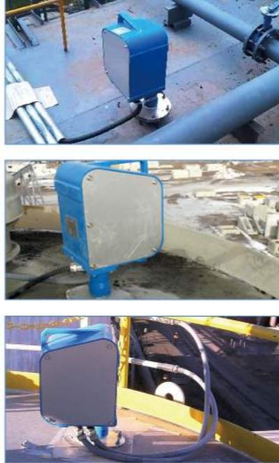
射频导纳物位计AP/APX 的结构分为：主电极和补偿电极。在主电极与补偿电极之间分别施加一组 RF 射频信号，因此具备良好的抗粘附、抗挂料等特性，是替代电容料位开关的新型物 / 液位测量仪表。
